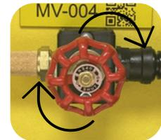
Fermer le dispositif, puis insérer le cadenas dans le trou aligné et s'assurer qu'il soit bien barré.
