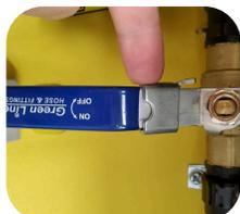
Ce mécanisme ne nécessite aucun dispositif pour être cadenassé. Seul le cadenas est nécessaire.
